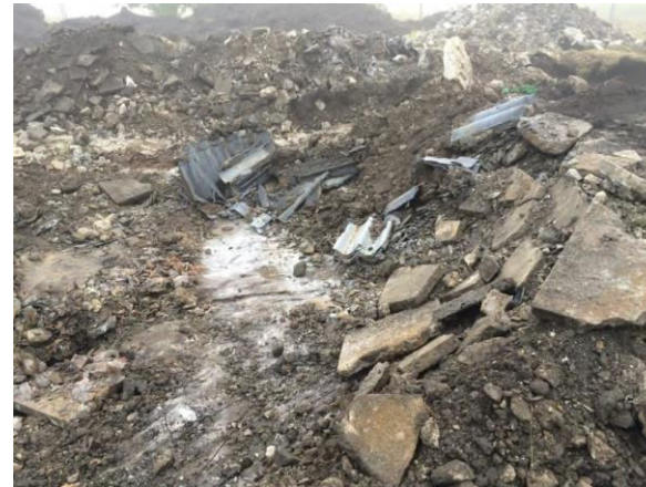
I alt blev omkring 300 tons asbestholdigt materiale kørt til deponi. Foto: Rambøll
