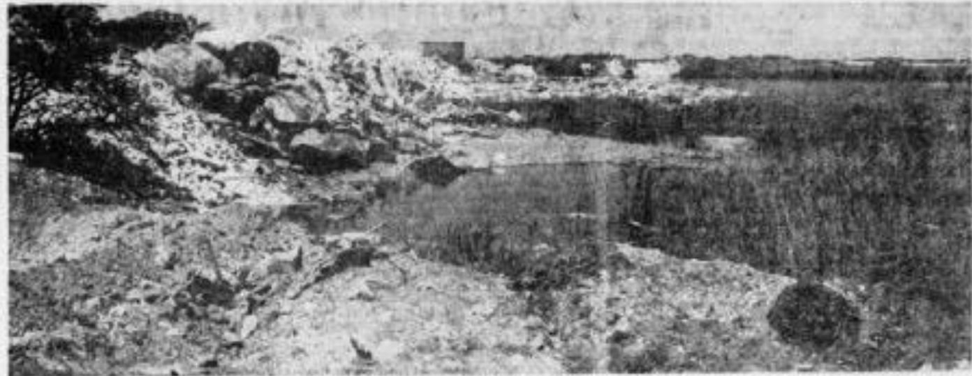
Nu afsluttes opfyldningen ved fabrikken Norden. Seer vil kun blive berørt nærmest Nordens kyst. Så skal af udrensning i vandhuller, grav- og kattegrave finde sted efter en plan.
