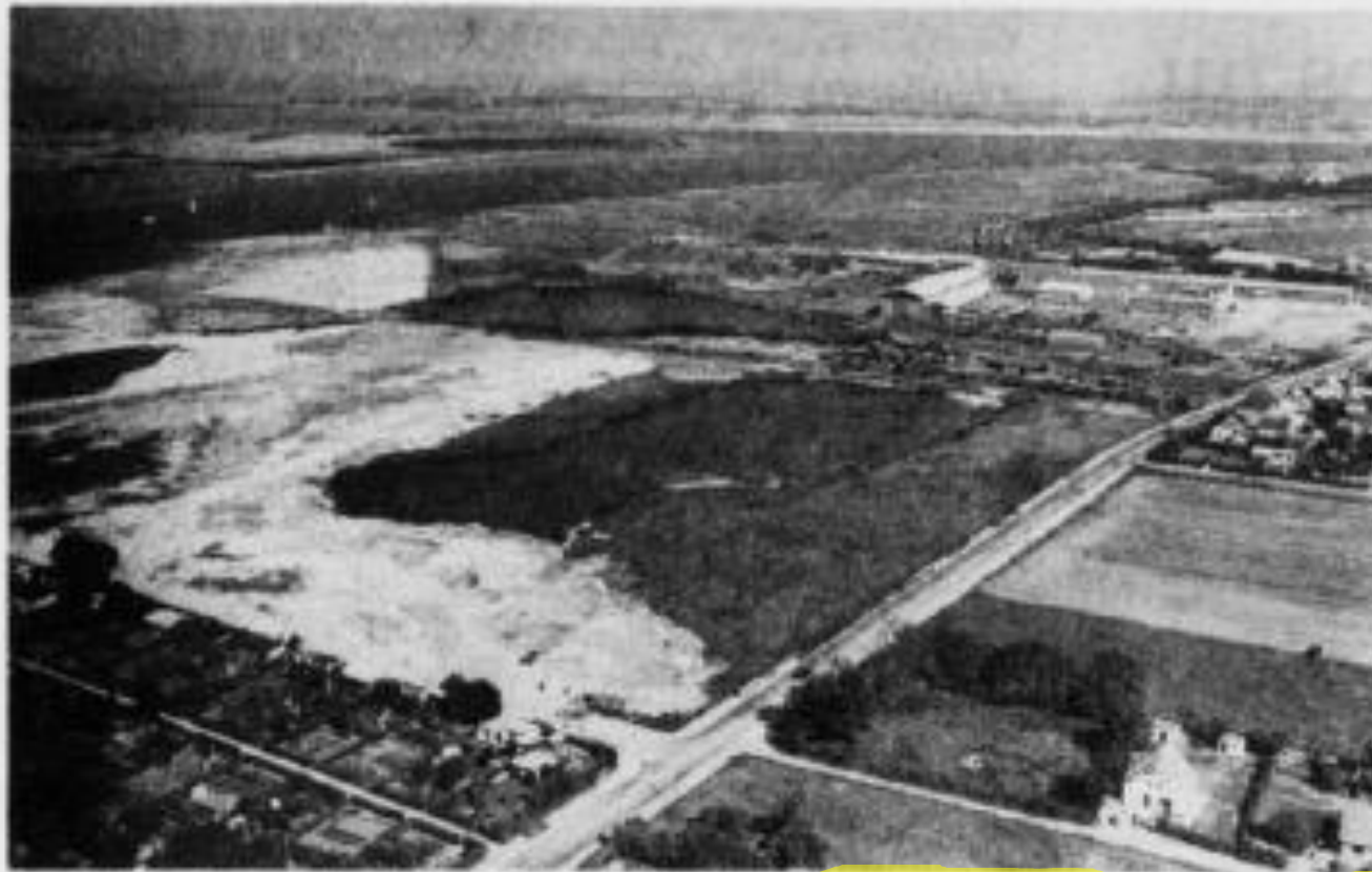
For øjeblikket ligger arealet omkring Melholt Sø ikke et rekreativt område. Alt det hvide på billedet er opfyldt materiale fra Dansk Cement-Fabrik. Nederst til venstre ses betonhavsområdet og øverst på billedet, ved den modsatte ende af søen, Maskinfabrikken Norden. (Foto: Max Rand)
